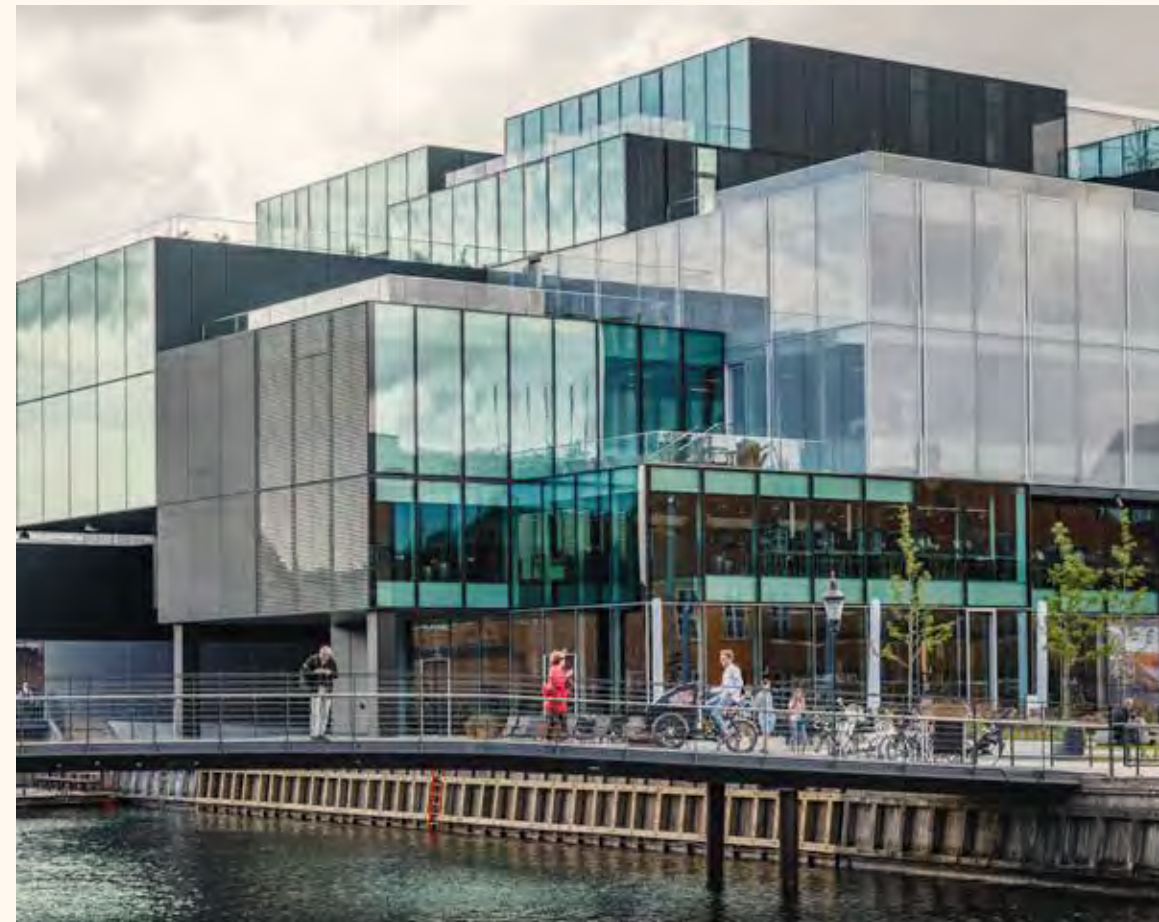
BLOX set fra Frederiksholms Kanal med gangbroen, der forbinder Søren Kierkegaards Plads med BLOX og Bryghuspladsen.
