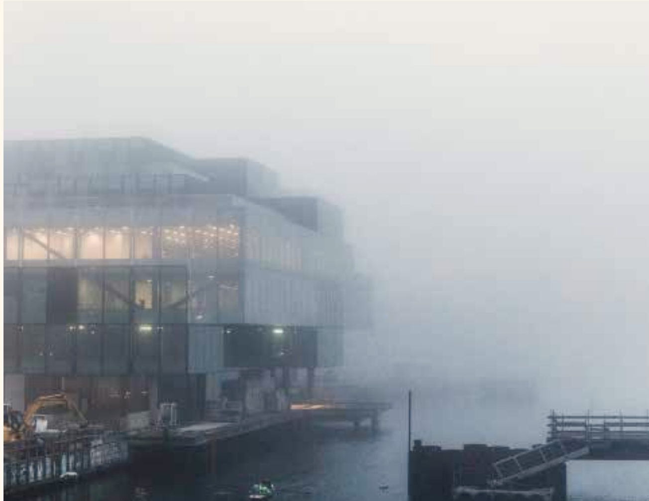
BLOX under opførelsen. Bygningen lægger sig helt ud til vandet som et venetiansk palæ, 2017.
