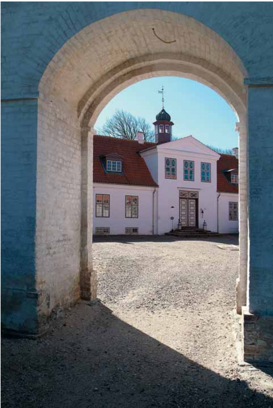
Borgens bygninger lukker sig omkring en lille gårdsplads.
