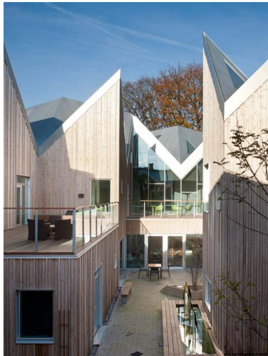
Det ligner det ikke - men her er tale om præfabrikation (fladelementer)
