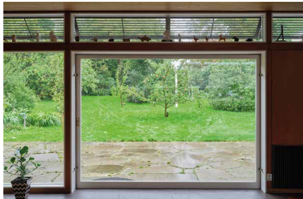
Langs glasfacaden til haven fik Lauritzen lagt varmerør i betonen for at tage kuldenedfaldet i overgangszonen mellem ude og inde, der er markeret med fliser.
