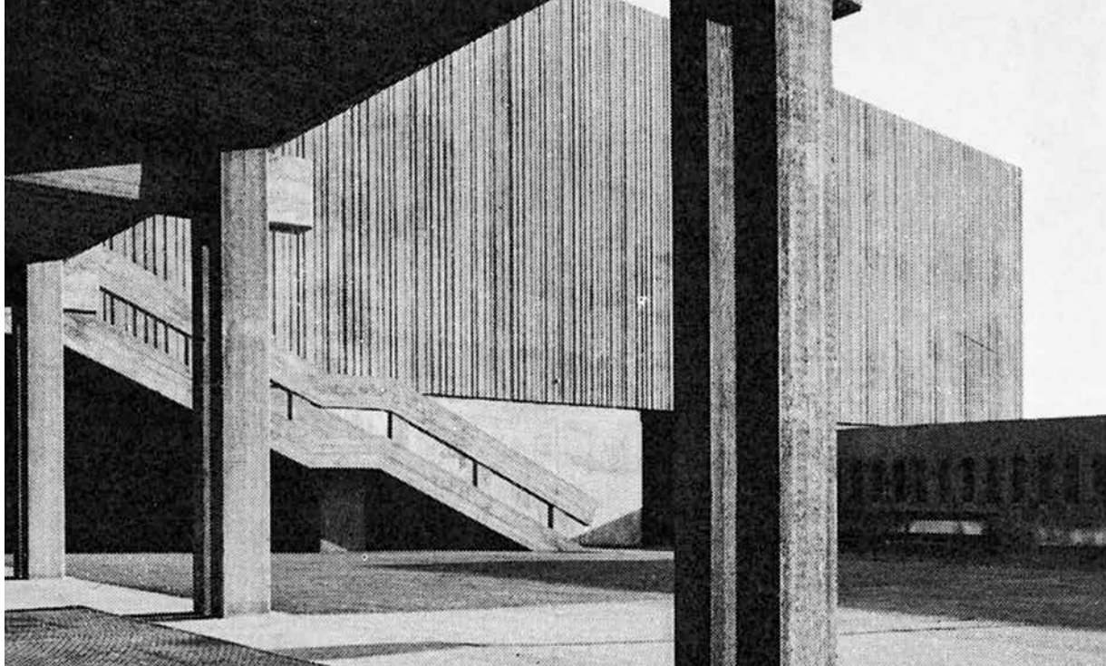
Der er klare lighedspunkter mellem Rundhøjskolen, som Knud Blach Petersen tegnede i 1960, og Glasalstrup, som han tegnede i 1964. Aftryk af grove, ru forskallingsbrædder går igen på begge bygninger.
